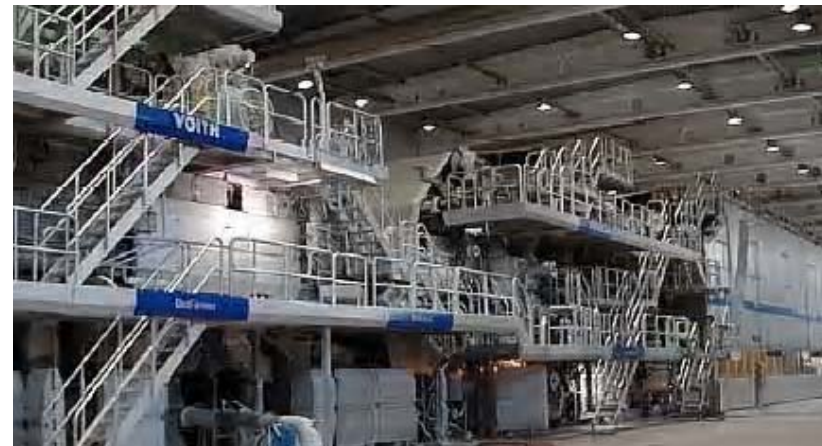
Nhà máy giấy
